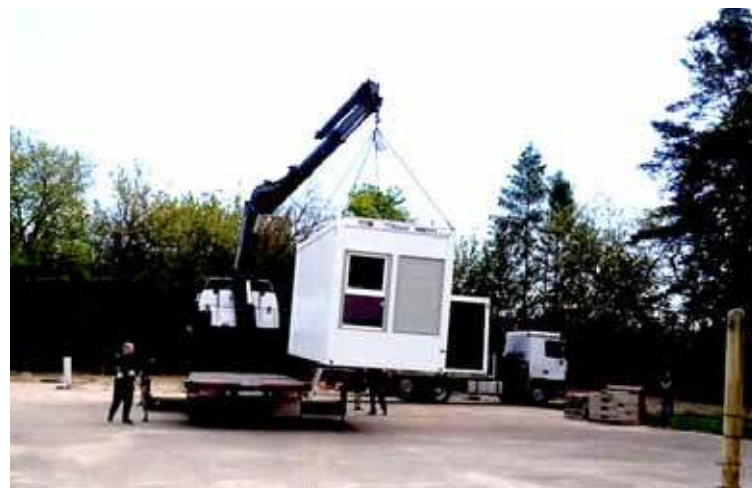
Rozładunek szkoły modułowej w Grzędzicach zdjęcie Damian Gralak
