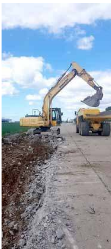
Pierwszym etapem prac jest kruszenie betonowych płyt
