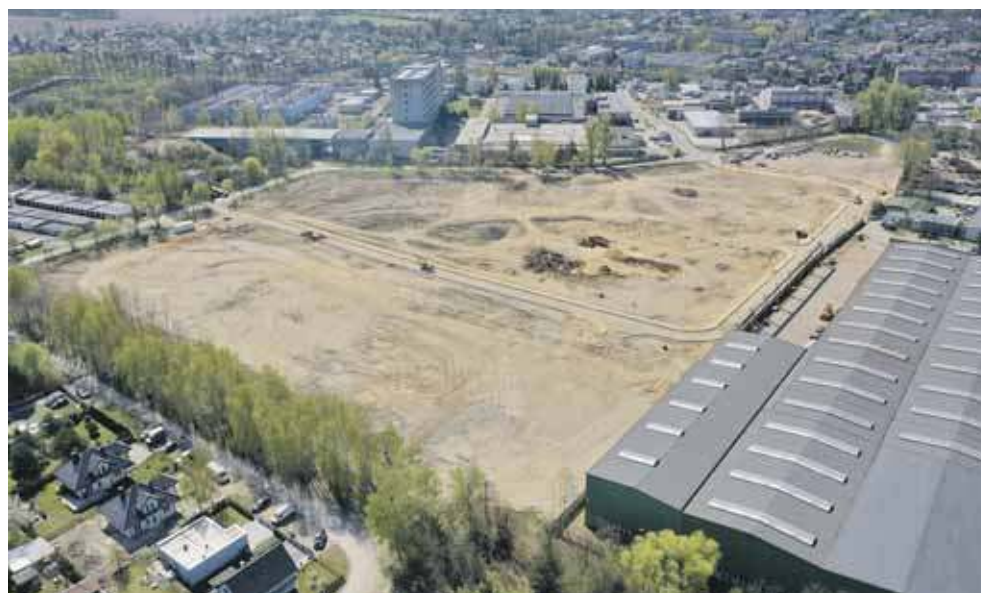
Prace w strefie gospodarczej przy ulicy Polnej dobiegły końca. Pojawiły się już ogłoszenia o przetargach na sprzedaż terenów inwestycyjnych
