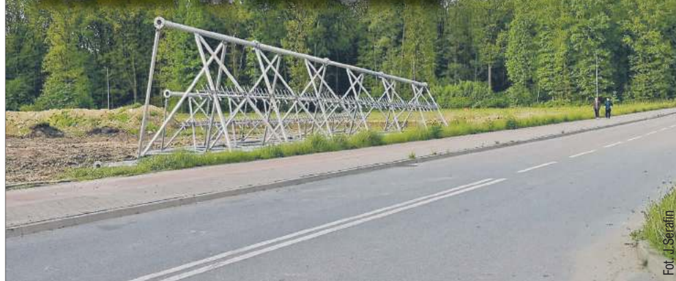
Zamontowane na maszcie anteny mają poprawić zasięg w trzech miejscowościach.
