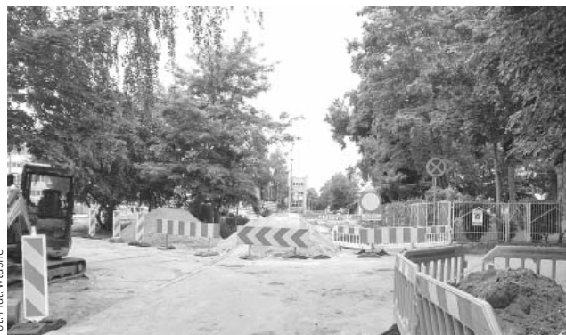
Budowa nowego skrzyżowania w Olsztynie
