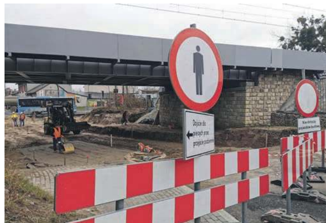
Wiadukt nad ul. Krakowską
