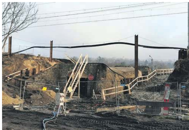
Wiadukt nad ul. Krasickiego
