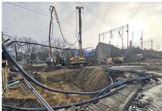
Przebudowa wiaduktu nad ul. Sienną
