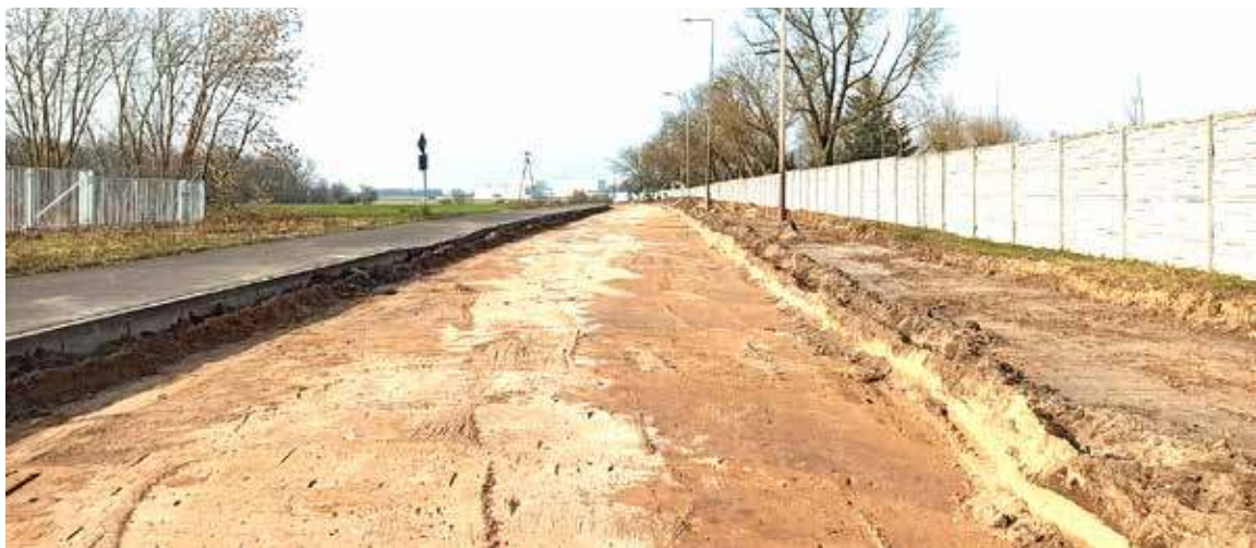
Roboty drogowe na Osiedlu Kluczewo idą pełną parą. Stare nawierzchnie dróg zostały zerwane
