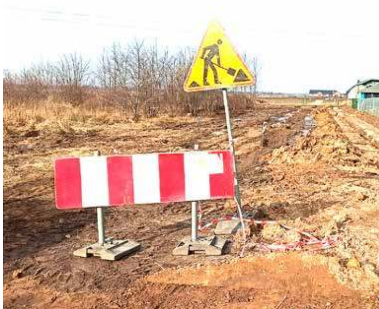
Rozpoczęły się roboty budowlane na ul. Chełmońskiego. Mieszkańcy zyskają drogę z kostki betonowej oraz chodnik. Zamontowane zostanie również oświetlenie LED
