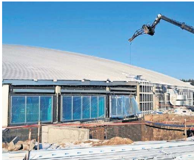
Hala sportowa w kompleksie Zawiszy do użytku zostanie oddana w połowie 2026 roku
