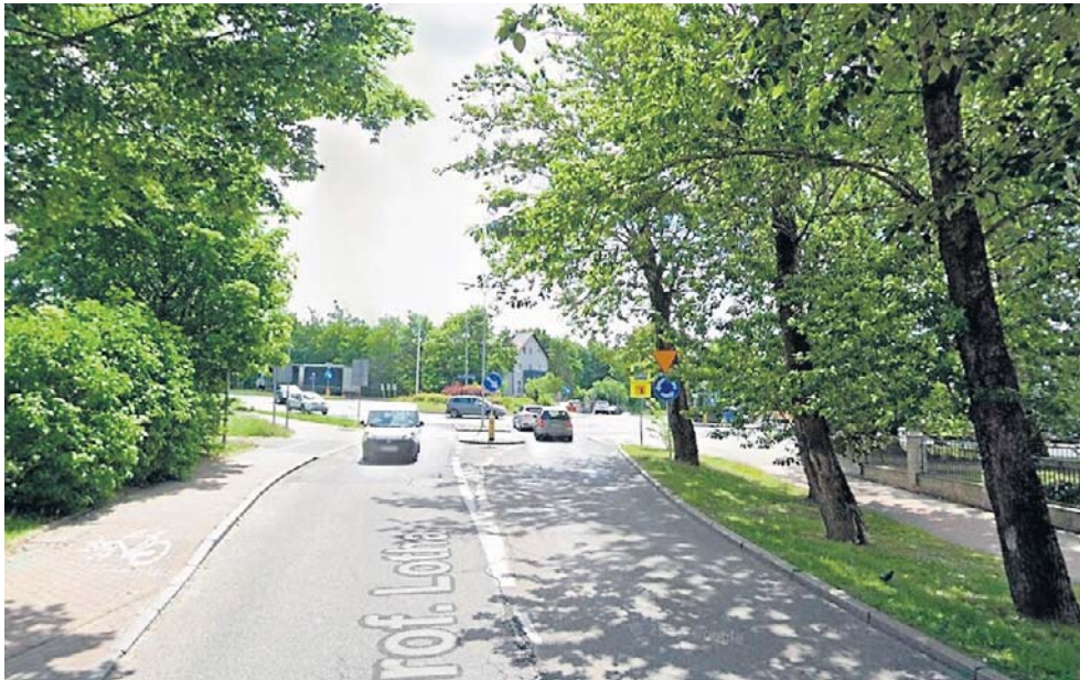
Ruch po mieście utrudnia modernizacja Ronda Staromiejskiego, zamknięta jest także w dużej części ulica Gdyńska. Na zdjęciu fragment ul. Lotha.
