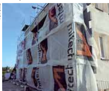
Remont kosztować będzie ponad 2 mln zł
