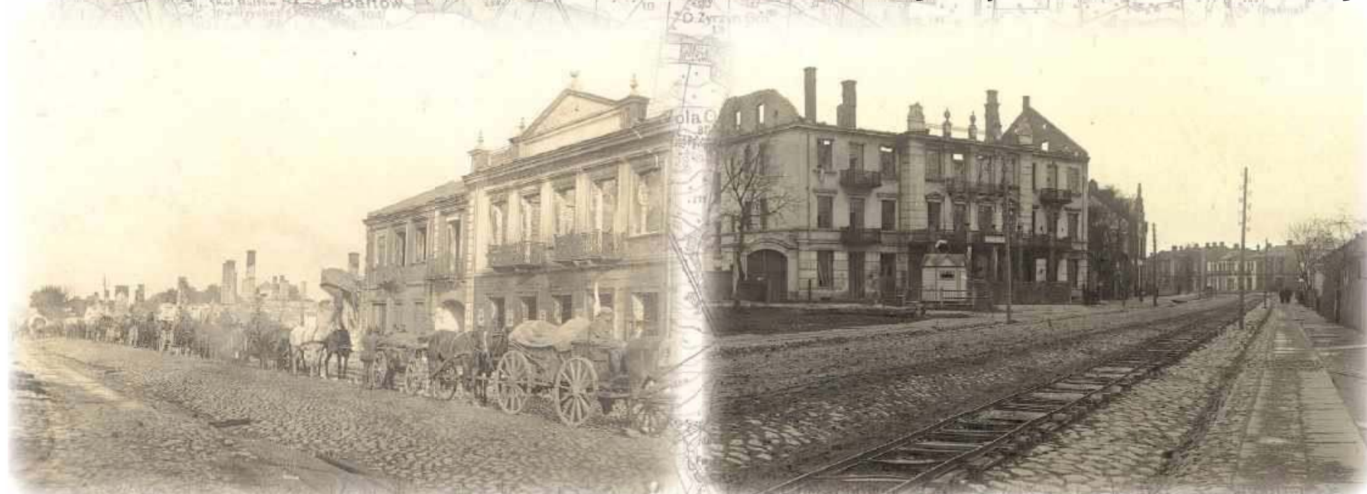
Zniszczona zabudowa usługowo-mieszkalna przy obecnej ul. Marszałka Józefa Piłsudskiego, 1915 r.
