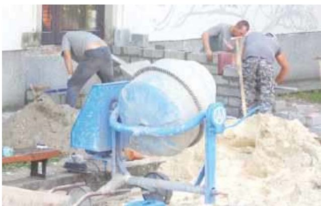
Do sali sportowej Szkoły Podstawowej w Chodlu od września prowadzić będą nowe schody
