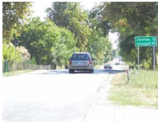
Mieszkańcy ul. Południowej co najmniej przez rok będą musieli jeszcze chodzić poboczem
