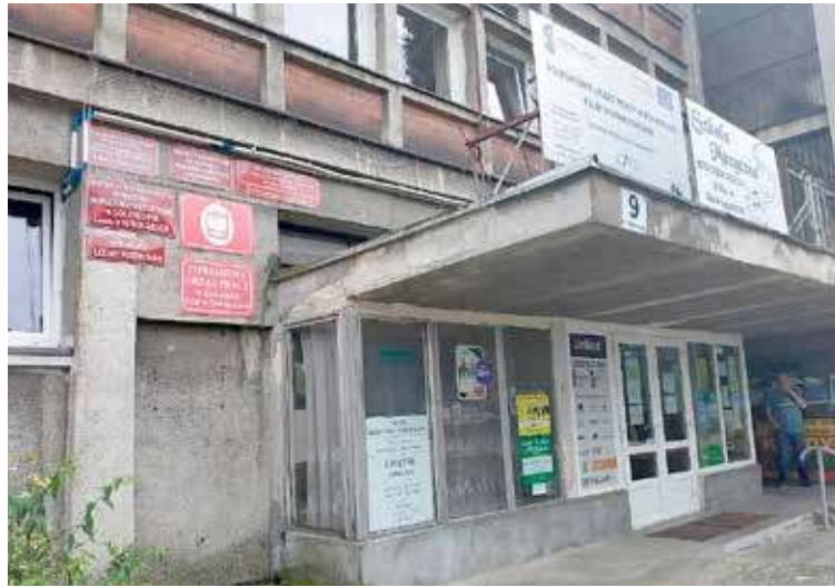
Wejście do budynku Cisy
