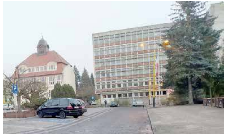
Budynek Cisy z pewnością nadaje się do remontu, ale problemem są jak zawsze fundusze, a w zasadzie ich brak
