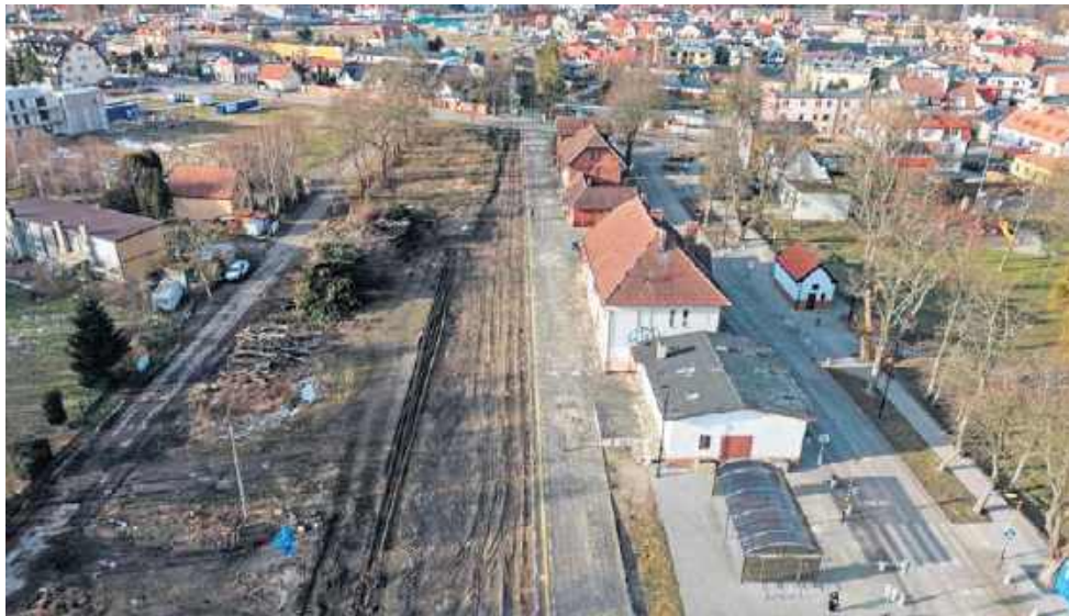
Trwa przebudowa linii kolejowej do Łeby. Latem pojedzie komunikacja zastępcza
