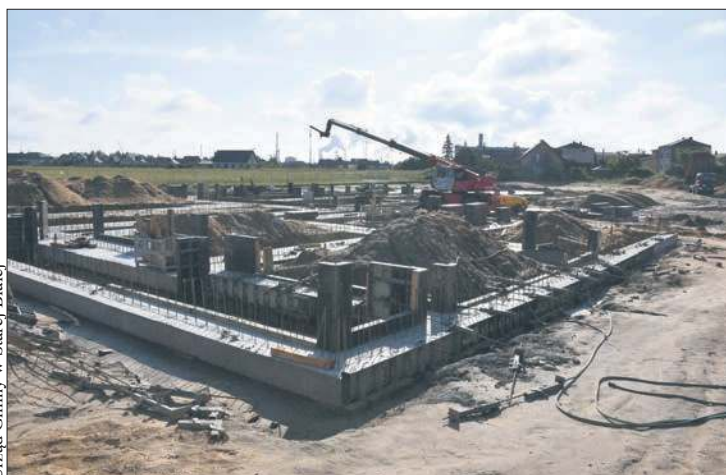
Trwa budowa żłobka i przedszkola w Maszewie Dużym
