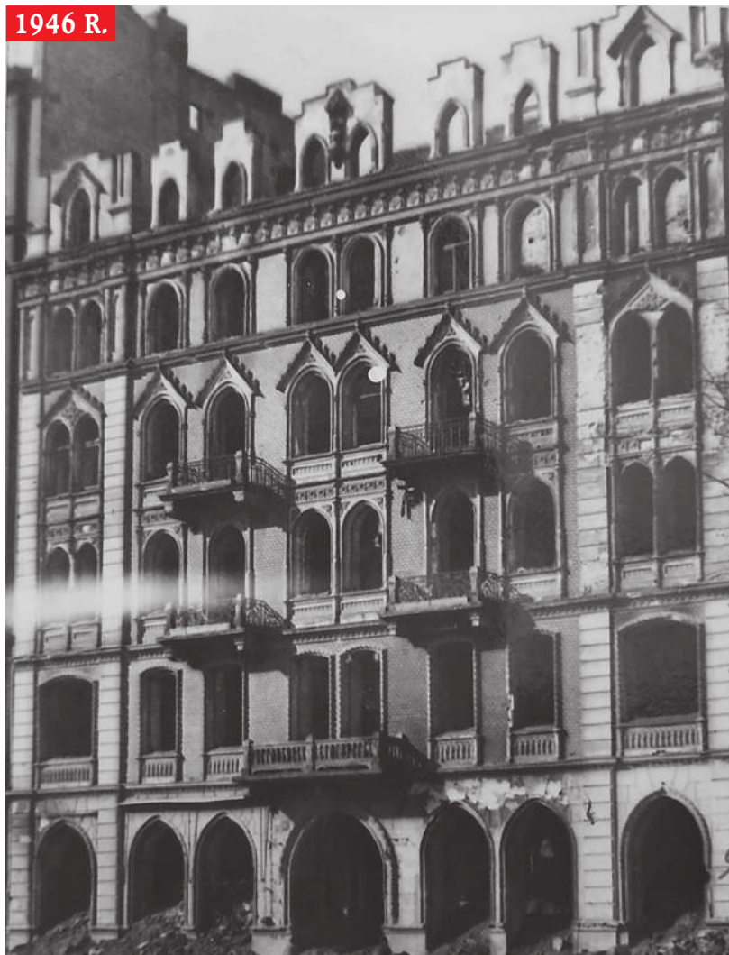
Spalona kamienica przy ul. Chłodnej 18 w 1946 r. Akta BOS-u. Zbiory Archiwum Państwowego w Warszawie
