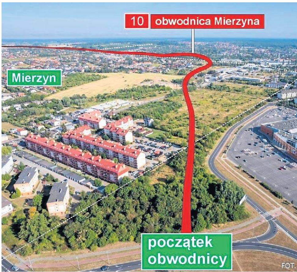
Początek obwodnicy na pograniczu Szczecina i Mierzyna
