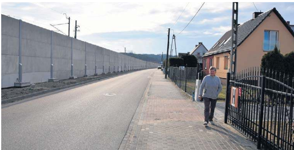
W pobliżu domów mieszkańców osiedla w Łęborku wyrósł betonowy mur
