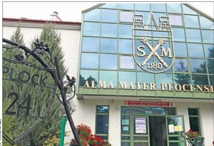
Jednym z obiektów przeznaczonych do modernizacji jest budynek LO im. Marsz. Małachowskiego
