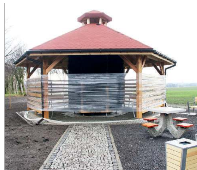
Oto tężnia, którą wybudowano w Pietrowicach Wielkich. Na razie jest jednak zamknięta.
