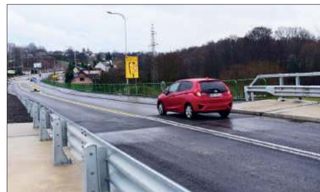
22 grudnia – po ponad roku od zamknięcia – wiadukt wzdłuż ul. Jastrzębskiej w Wodzisławiu Śl. znowu jest przejezdny
