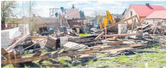
Silny wiatr uszkodził budynki mieszkalne, gospodarcze, ogroduzenia posesji, zaparkowane samochody oraz połamał drzewa.
