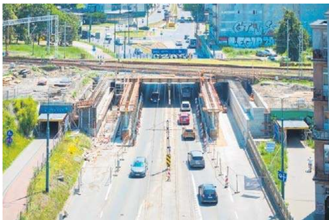
W Sosnowcu kolej znów otwiera przejazd pod wiaduktem na ulicy Piłsudskiego w centrum miasta
