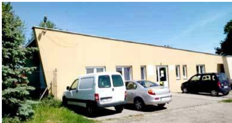
W ramach prac remontowych wymieniono dach nad Schroniskiem dla Bezdomnych Zwierząt
