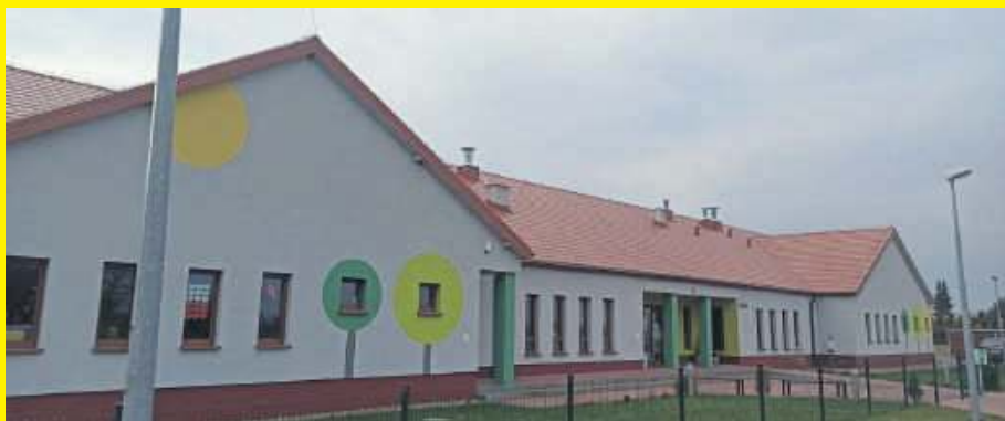
W przedszkolu w Kondratowicach strażacy zakreśliли główny zawór na wyjściu ze zbiornika gazu
