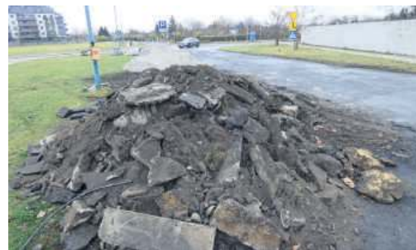
Remont ul. Okulickiego już się zaczął. Apelujemy do kupujących i handlowców o szczególną ostrożność
