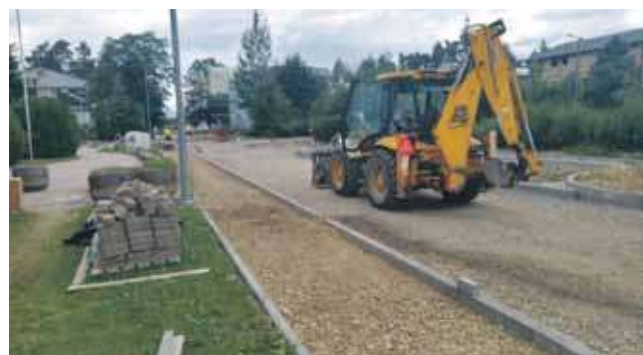
Ulica Sądowa w Nowym Targu - w trakcie robót budowlanych.
