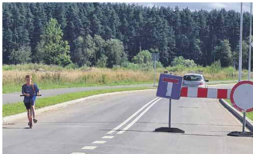
To ostatni fragment wschodniej obwodnicy miasta, która kierowcom jadącym od Kowańca pozwoli przedostać się na południe, omijając centrum.
