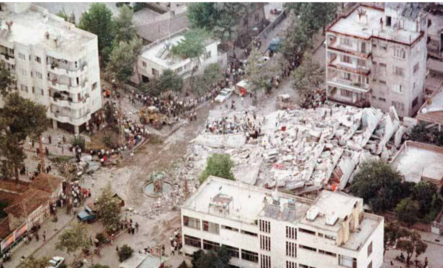
Fot. 1. Turcja, Adana – widok z lotu ptaka na zniszczenia wywołane trzęsieniem ziemi o sile 6,3 stopni w skali Richtera w czerwcu 1997 r. (fot. PAP EPA/STF)
