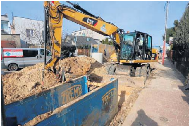
Na kolejnym odcinku ulicy Wiejskiej rozpoczęła się wymiana rur sieci kanalizacyjnej i deszczowej
