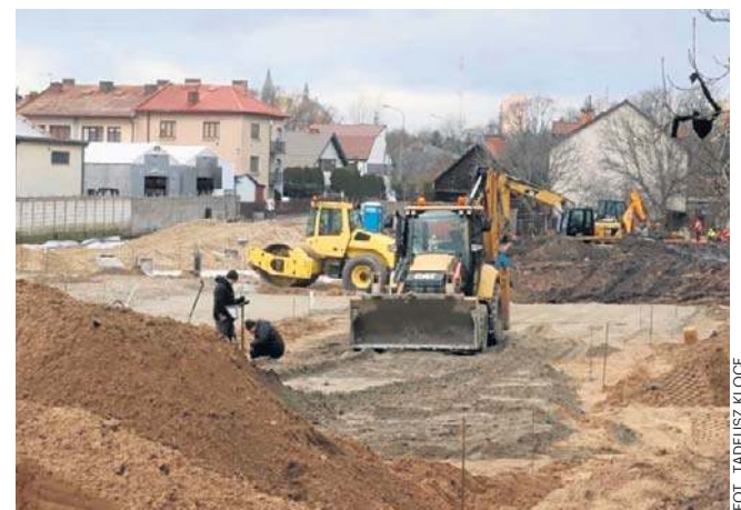
Na tyłach sanepidu trwa budowa nowego parkingu oraz przedłużenia ulicy Piwnej do ulicy Zgodnej
