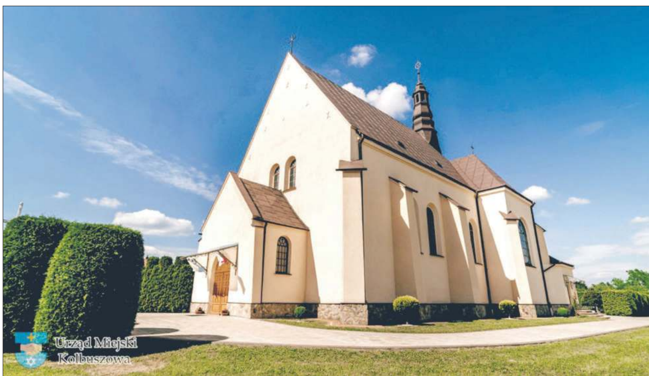
Kościół parafialny pw. NMP Królowej Polski został wzniesiony w latach 1920-1935. W ciągu dekady został odnowiony dach budynku oraz elewacja. Położono także kostkę brukową dookoła kościoła.
