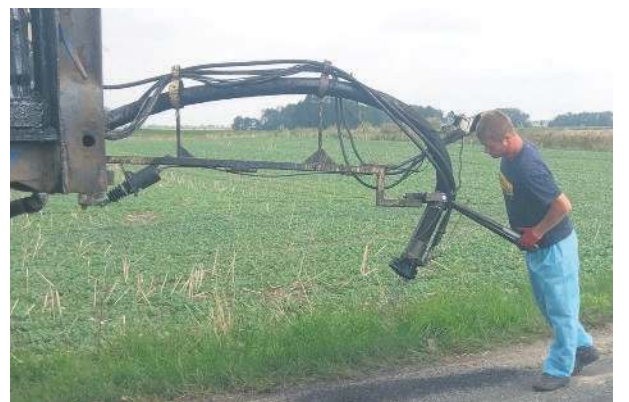
Na początku sierpnia rozpoczęły się remonty patcherem w okolicach Kłosowa
