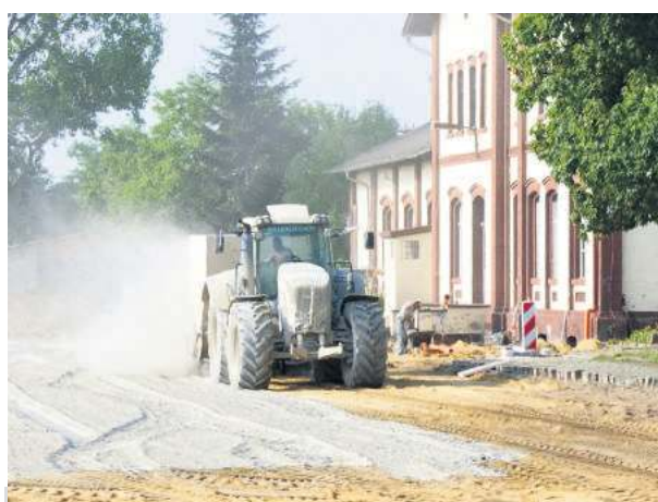
Na przystankowym parkingu w Boreczku trwa wzmacnianie podbudowy drogi
