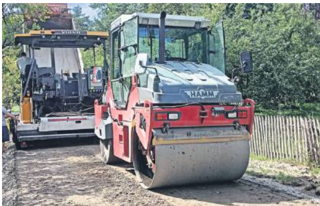
Budowa drogi w miejscowości Szur pod Krasnobrodem.
