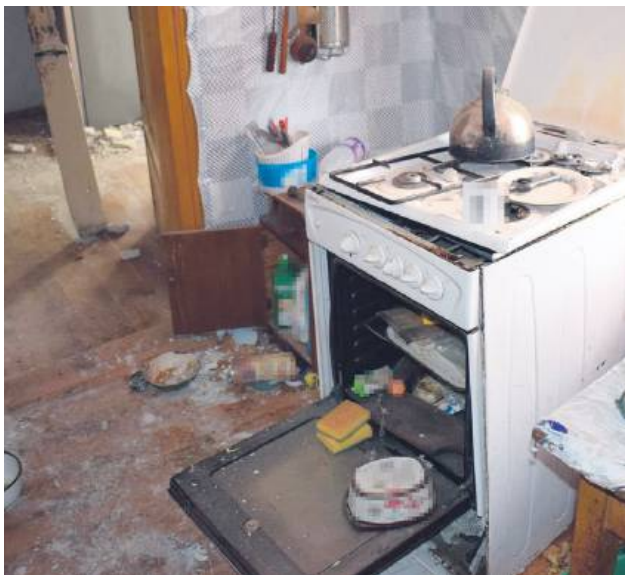
Po wybuchu w budynku popękały ściany.
