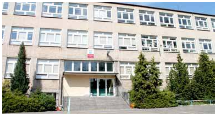
Ze względu na zwiększone potrzeby lokalowe Zespół Szkół Budowlano-Technicznych z obecnej lokalizacji przeniesiony zostanie do budynku przy ulicy Ceglanej 11, gdzie funkcjonowało Gimnazjum Gminne
