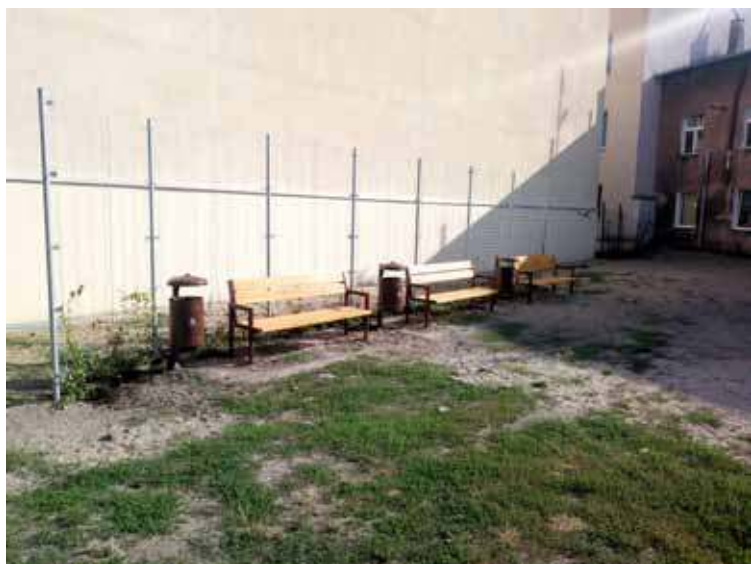
Przy ul. Wojska Polskiego 78A zamontowano ławki oraz pergolę, posadzono także rośliny
