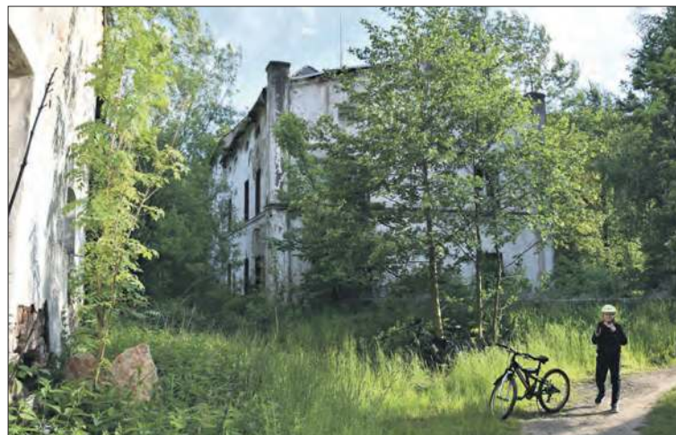
Budynek mieszkalny w 2020 roku
