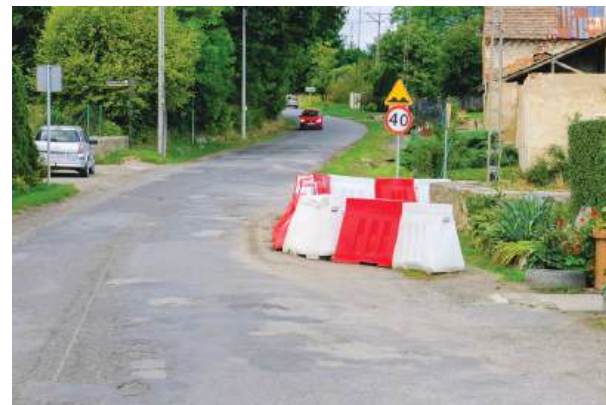
Kamienny przepust w Cierpicach, który pełni rolę mostu, uległ zniszczeniu podczas powodzi
