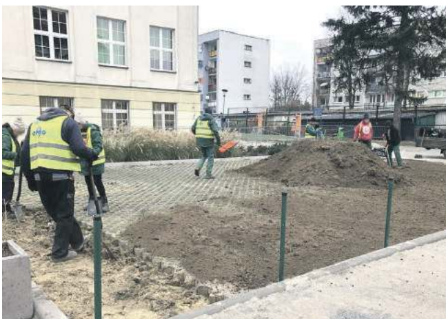
Tak pracownicy gminnej spółki komunalnej Ergo zasypywali ułożoną wcześniej ażurową kostkę betonową przed Szkołą Podstawową nr 1 w Trzebnicy. Gdy zapytaliśmy o koszty i dokumenty, odpowiedzi nam nie udzielono. Zrobiono to dopiero wtedy, gdy sprawa trafiła do prokuratury
