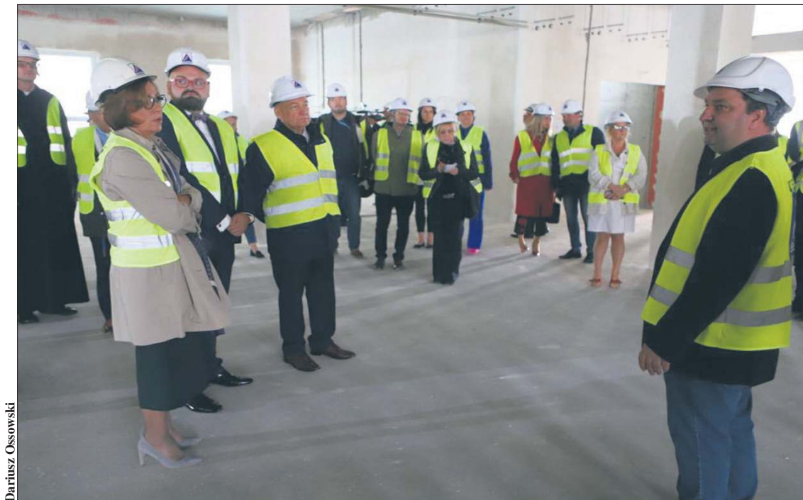
Budowa Ośrodka Radioterapii w Płocku idzie zgodnie z planem
