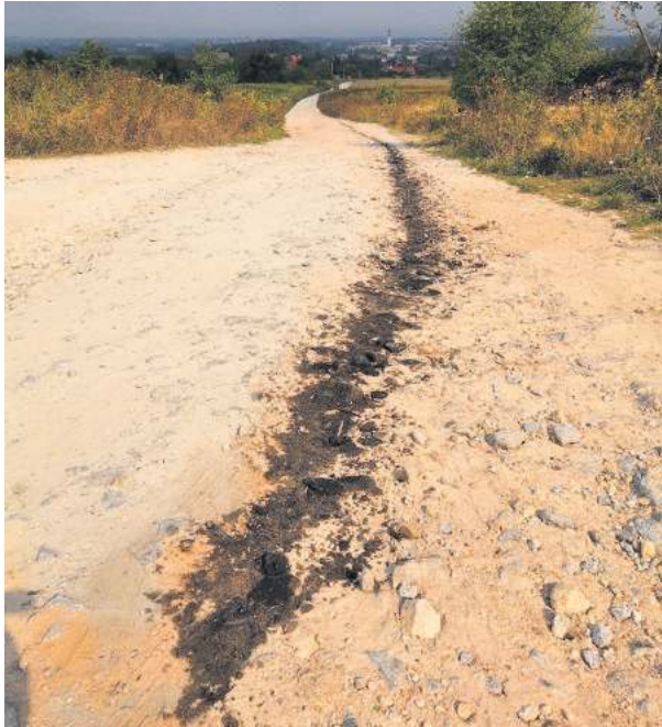
Smugę wyciekającego z samochodowej miski oleju widać było od szczytu ul. Sosnowej aż do sklepu przy ul. Staromiejskiej
