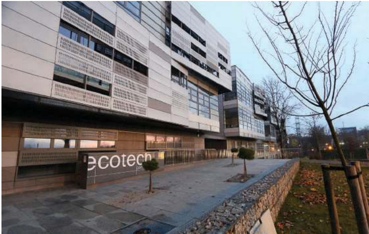
Budowa i wyposażenie obiektu kosztowało ponad 145 milionów złotych
