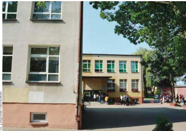
Olecka „Jedynka” być może doczeka się termomodernizacji w przyszłym roku
