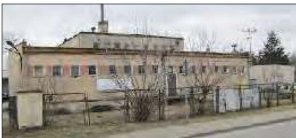
Widok nieruchomości budynkowej od strony ul. Grunwaldzkiej
