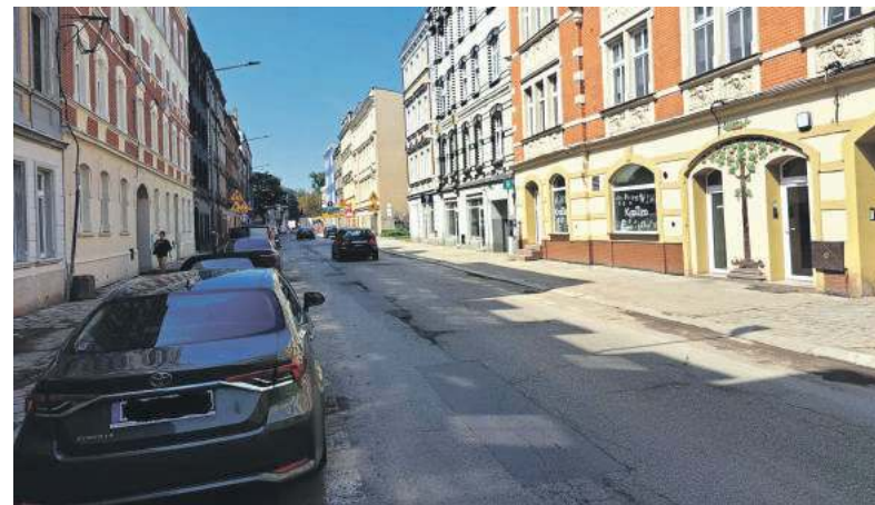
Inwestycja warta 50 mln zł ma zażegnać problem z zalewaniem ul. Piłsudskiego po ulewnych nawałnicach
