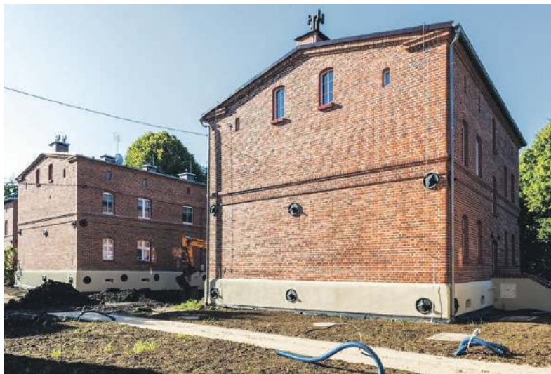
Po oczyszczeniu ceglanej elewacji familoki prezentują się wspaniale
