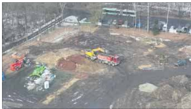
Trwa budowa stadionu lekkoatletycznego w Jaworznie
