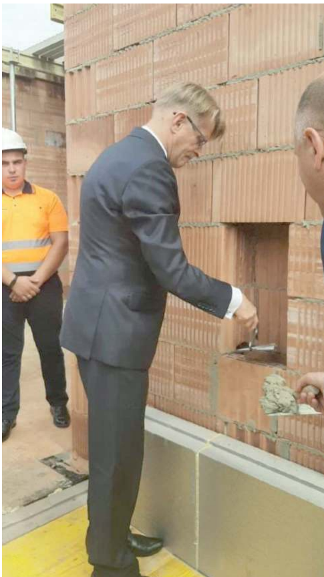
Kielnia w dłoń, zaprawa na nią. Starosta Dariusz Szustek z „murarką” poradził sobie całkiem dobrze
