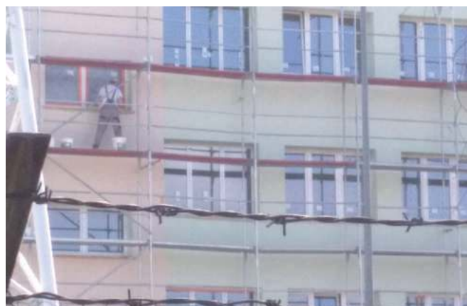
W piątek przy budynku bialskiego Strzeżonego Ośrodka dla Cudzoziemców trwały prace remontowe
