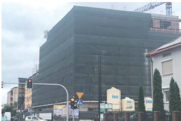
Komorowskiego Corner - inwestycja budowana w Biłgoraju
