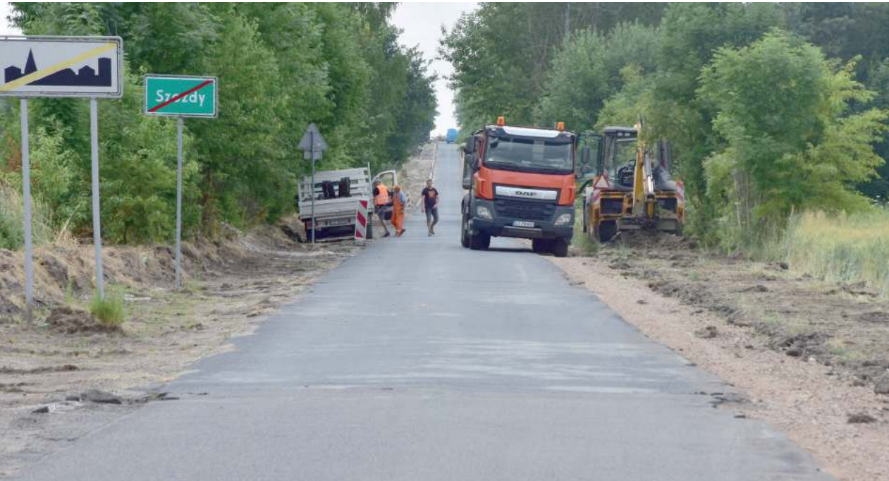
Przy przystankach autobusowych pojawiają się zatoczki. Pobocze będzie umocnione kruszywem
