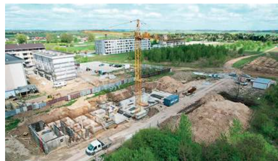
Powstające budynki przy ul. Powstańców Wielkopolskich
