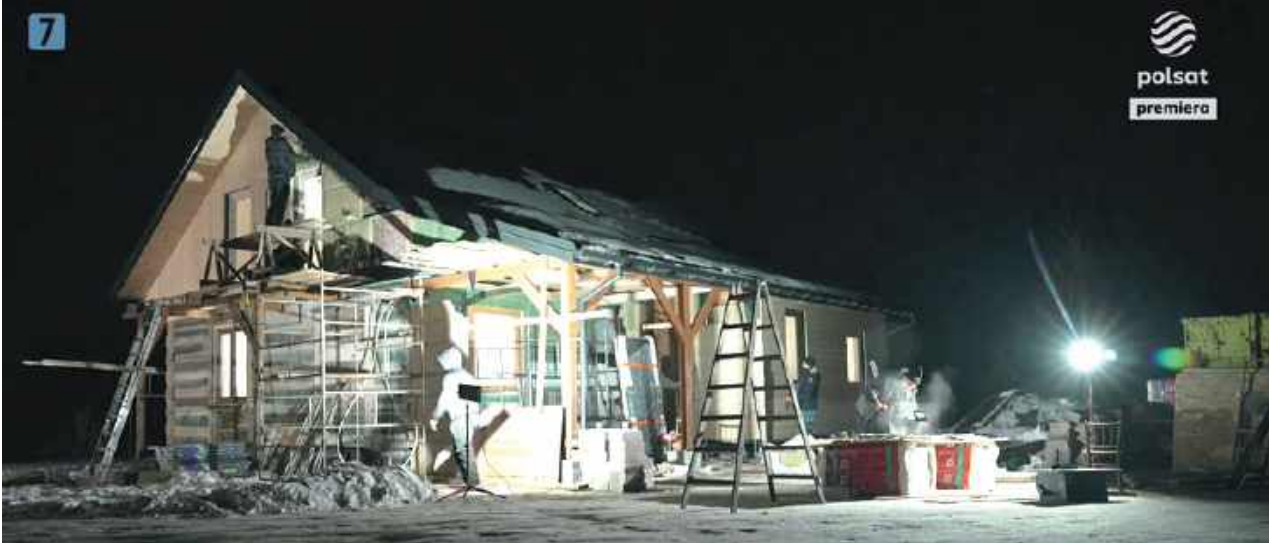
Zdj. Screen z odcinka. Ekipa remontowa kontynuowała prace także nocą, wskazując na duży zakres robót wynikający z liczby pomieszczeń w budynku. Szczególną uwagę zwrócili na konieczność odpowiedniego zabezpieczenia elewacji – zastosowano folię ochronną oraz nagrzewnice, aby umożliwić prowadzenie prac w niskich temperaturach. W ramach dostosowania przestrzeni do potrzeb najmłodszych mieszkańców domu zamontowali również oświetlenie nawet schodów
