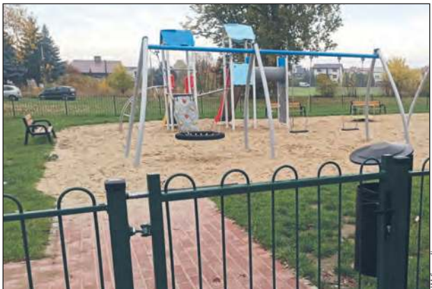
➤ Urządzenia do zabawy zostały usytuowane na części placu pokrytej 40-centymetrową warstwą piachu
