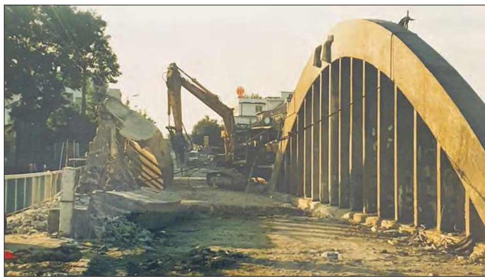
➤ W 1999 r. most z łukami rozebrano ze względu na stan techniczny. Na jego miejscu powstał nowy, ale już bez łuków.
