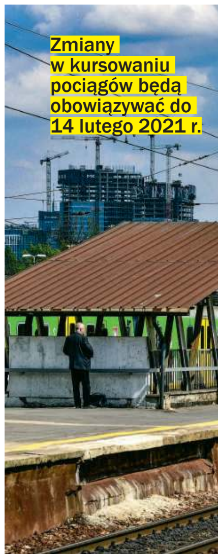
Stacja Warszawa Zachodnia to największy kolejowy węzeł komunikacyjny.
