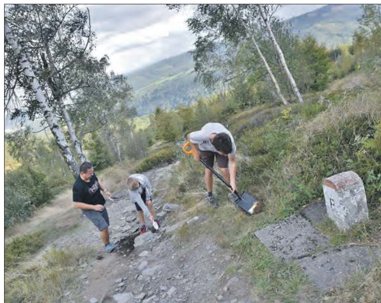
Słup zabezpieczony został 21 września
