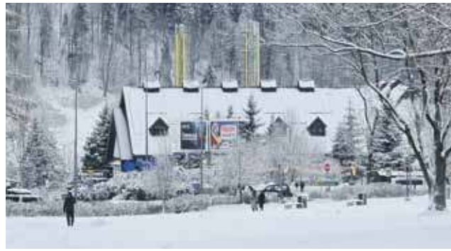
Geotermalna kotłownia w Zakopanem
