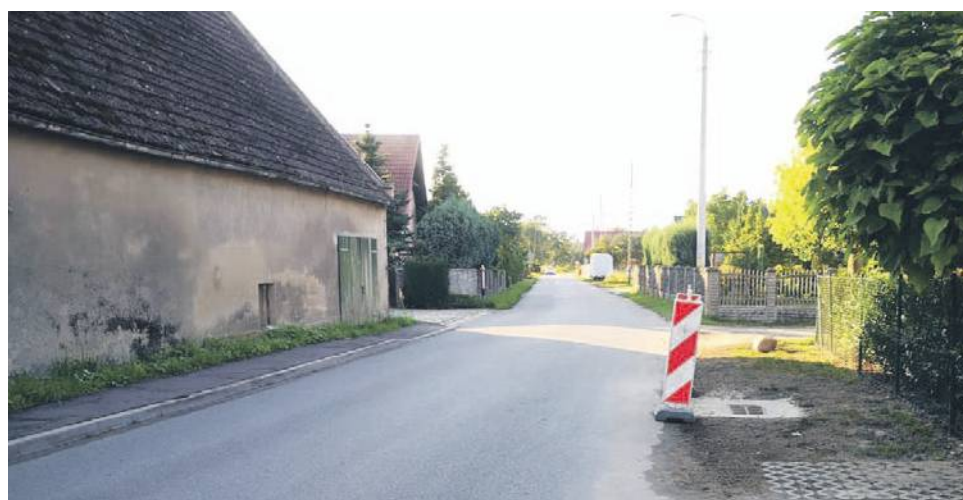
Tutaj kończy się chodnik po lewej, a rozpocznie budowa dalszego ciągu po prawej
